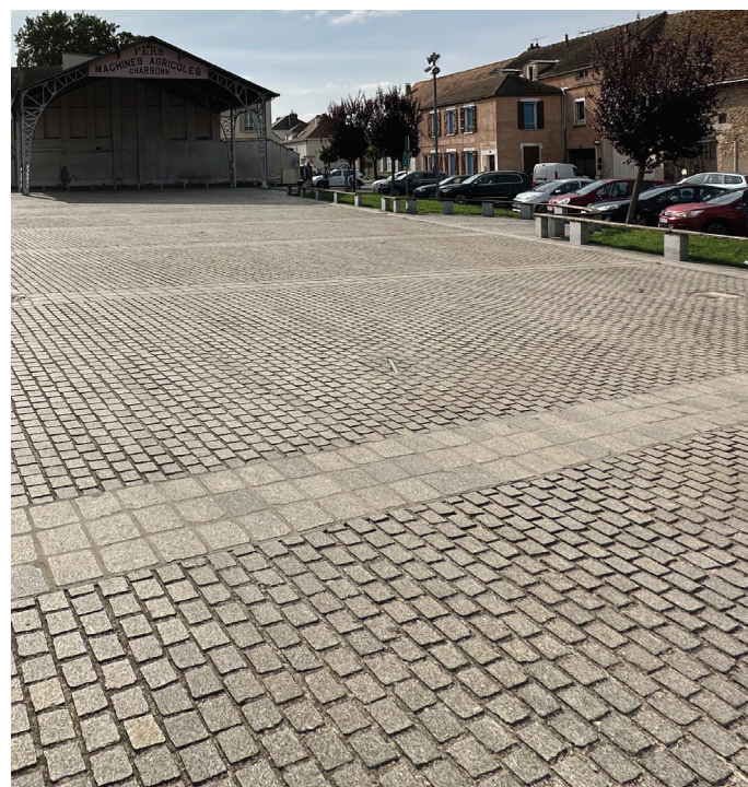
Centre ville d'Auneau - parvis de l'espace Dagron
